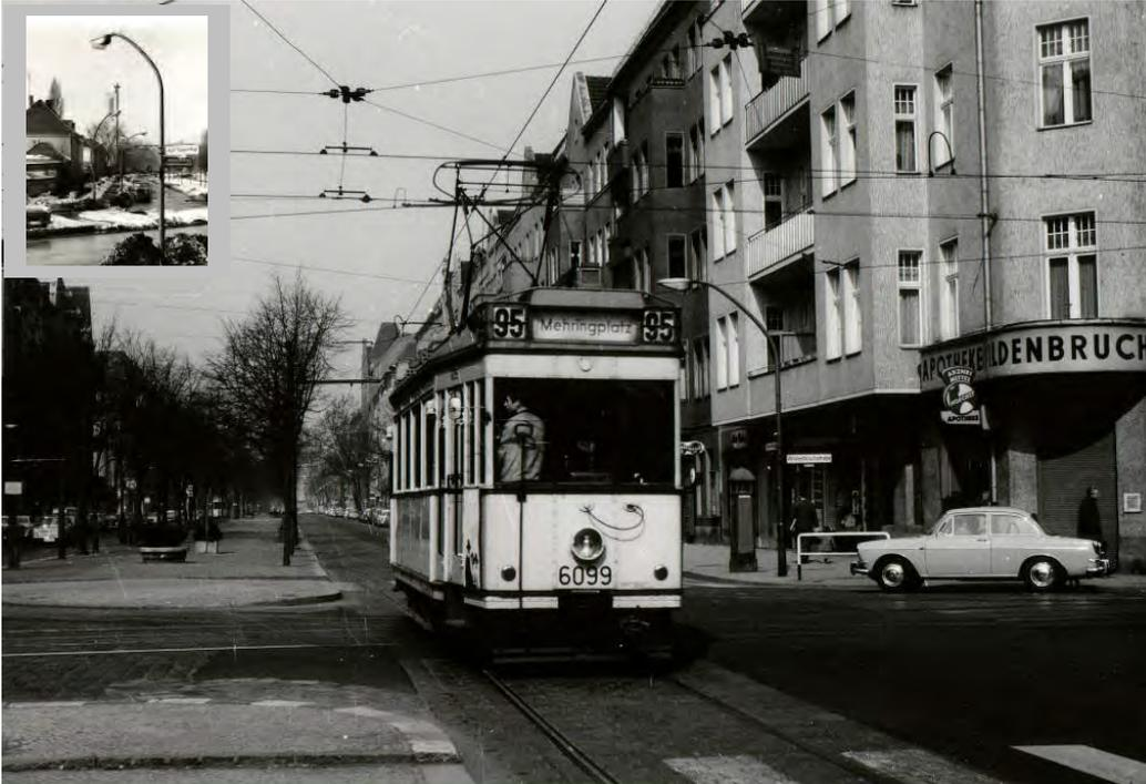
Die Linie 95 Anfang 1960 auf der Sonnenallee/Ecke Wildenbruchstraße in Neukölln. Die Sonnenallee wurde damals mit Gas-Reihenleuchten des Modells U13B beleuchtet. Sie waren an den dafür vorgesehenen Lichtmasten mit zweifach abgelenktem Ausleger montiert. Linie 95 verband ursprünglich einmal Schöneberg mit Köpenick, war aber zu Beginn der 1960er Jahre nur noch ein Torso und fuhr zuletzt lediglich noch zwischen Mehringplatz und der Sonnenallee. Am 1. Mai 1965 war auch für diese Linie Feierabend.
