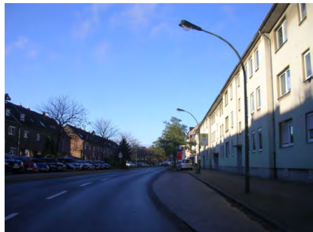
Gasleuchten auf beiden Seiten der Kürtenstraße. Links Aufsatz- und rechts Reihenleuchten (Aufnahme Herbst 2012), Bild: Thomas Schmitz
