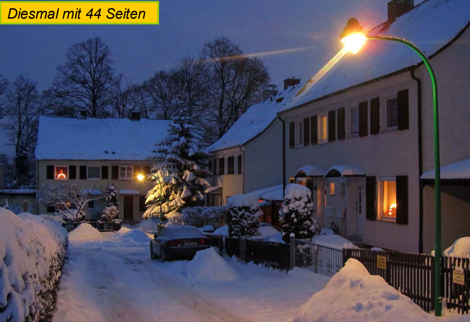
Chemnitz: Tief verschneit zeigt sich die Waldleite mit der Gagfah-Siedlung im Dezember 2012. Die Ansatz-Gasleuchten des Modells „Bamag U11“ stehen unter Denkmalschutz. Foto: Holger Drosdeck
