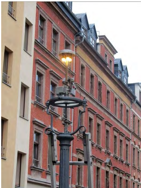
Aufbau und Installation in der Ottostraße
