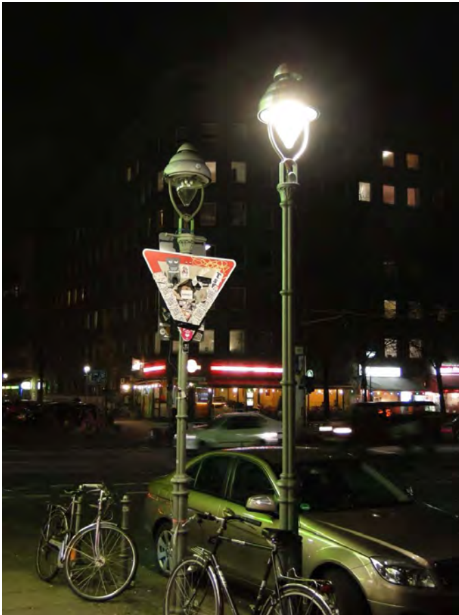
Links das abgeschaltete Original, rechts die LED-Attrappe, aufgenommen an der Kreuzung Falckensteinstr./Schlesische Straße
