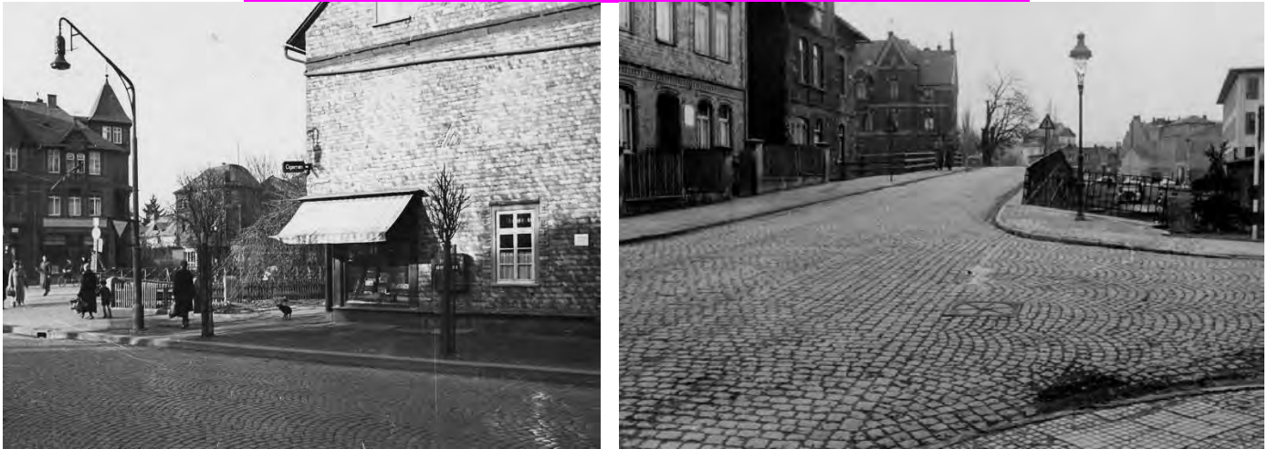
Links: Gashängeleuchte am Buderusplatz um 1936, rechts Aufsatzleuchte in der Sophienstraße um 1955, Bilder: Stadtarchiv Wetzlar
