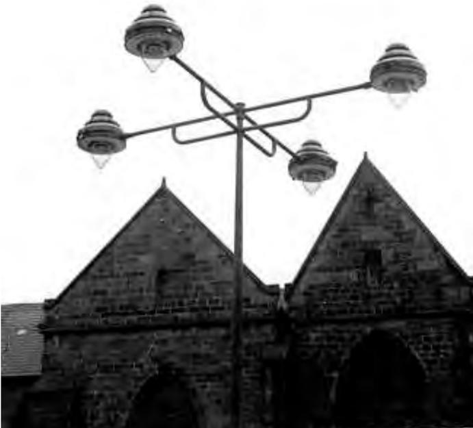
*Minden um 1976: Eine Vierfach-Ansatzbeleuchtung von Rech an einem Benteler-Stahlmast.*
