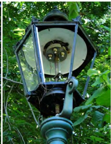
Die Palette der Schäden und Mängel reicht von diversen Vogelnestern, zerschlagenem Glas, zerstörten Gehäusen oder verschmutzten Reflektoren bis zu fehlenden Brennern und Glühkörpern oder nicht ordnungsgemäß montierten Dächern. Zehn Laternen-Aufsätze fehlten, in vier Fällen hatte man „Ersatz-Gasleuchten“ auf die Kandelaber montiert. Das Freilichtmuseum ist in einem extrem schlechten Zustand und derzeit nicht präsentabel. Weitere Bilder auf der folgenden Seite. Bilder: Joachim Raetzer
