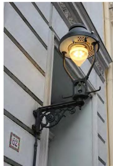
*Lübecks klassische Altstadtbeleuchtung: Eine Gas-Aufsatzleuchte der Fa. Vulkan, Modell 87, mit der für Lübeck typischen Rhenag-Glocke mit Blending, Bild: Oliver Frühschütz*
