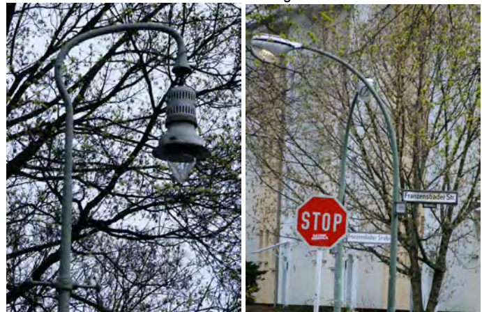
Links: Schwanenhals-Mast der Fa. Lehmann & Feyerabend (Manfey) in der Delbrückstraße; rechts Gas-Reihenleuchte an der Kreuzung zur Franzensbader Straße
