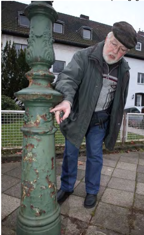
Alfred Metzler ärgert sich über angerostete Gusskandelaber
