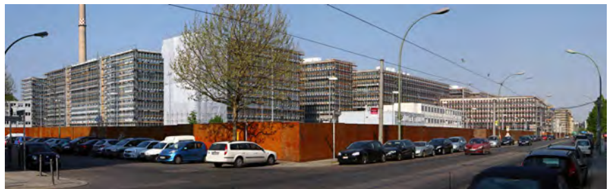
BND-Baustelle an der Ecke Chausseestr./Habersaathstr. (2011), Bild Architektur-Forum
