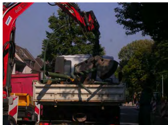
Abriss von Gas-Reihenleuchten, Bild: Thomas Schmitz
