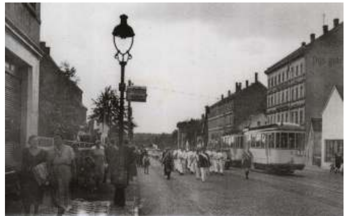
Aufsatzleuchte „Bauart Köln“ im Jahr 1935. Markant für Leipzig ist, dass die Laterne auf einem eigentlich zu einer Modellleuchte gehörenden Bügel montiert ist.
