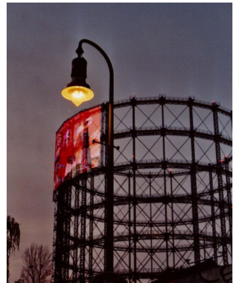
Berlin-Schöneberg (2009): Noch leuchtet eine Gas-Hängeleuchte vor dem Gerüst des Gasometers. Foto: Bettina Grimm
