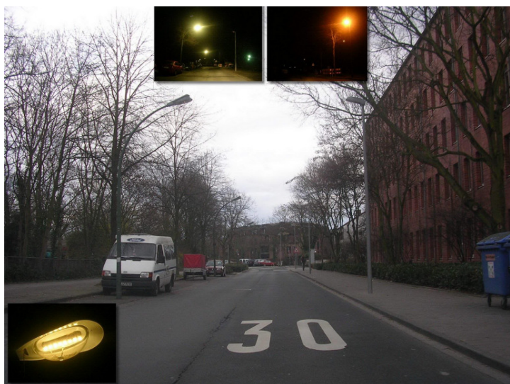
In einer Tempo-30-Zone werden Gas-Reihenleuchten abgerissen und durch Lumega-Natriumdampfleuchten ersetzt.
