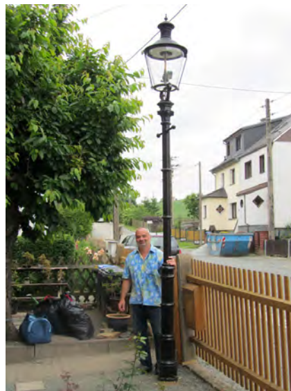
Die Installation der Rundmantellaterne auf einem Bündelpfeiler ist im Sommer 2010 abgeschlossen.
