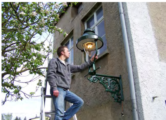
Die Nummer Zwei folgte wenig später: eine Aufsatzleuchte (Untergestell ehemals Typs Leistner, jedoch mit Stahldach). Der Wandarm stammt aus Düsseldorf.
