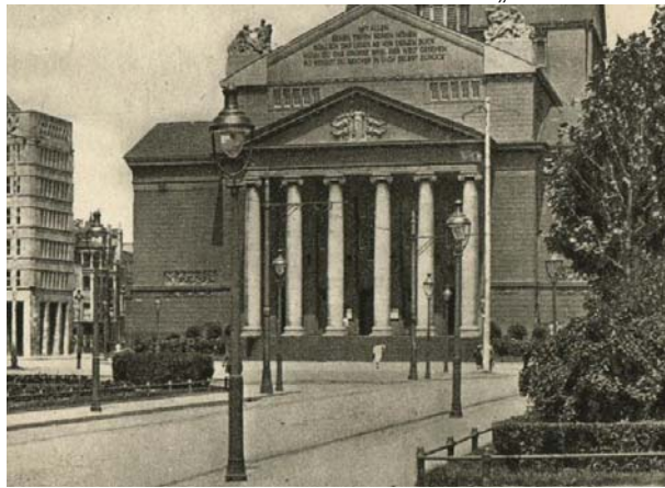
Am Duisburger Stadttheater: eine ganze Armada von Gaslaternen (gr. Modell Köln / Nummer 50 von Vulkan auf Vulkan-Mast Kölner Bauart)
