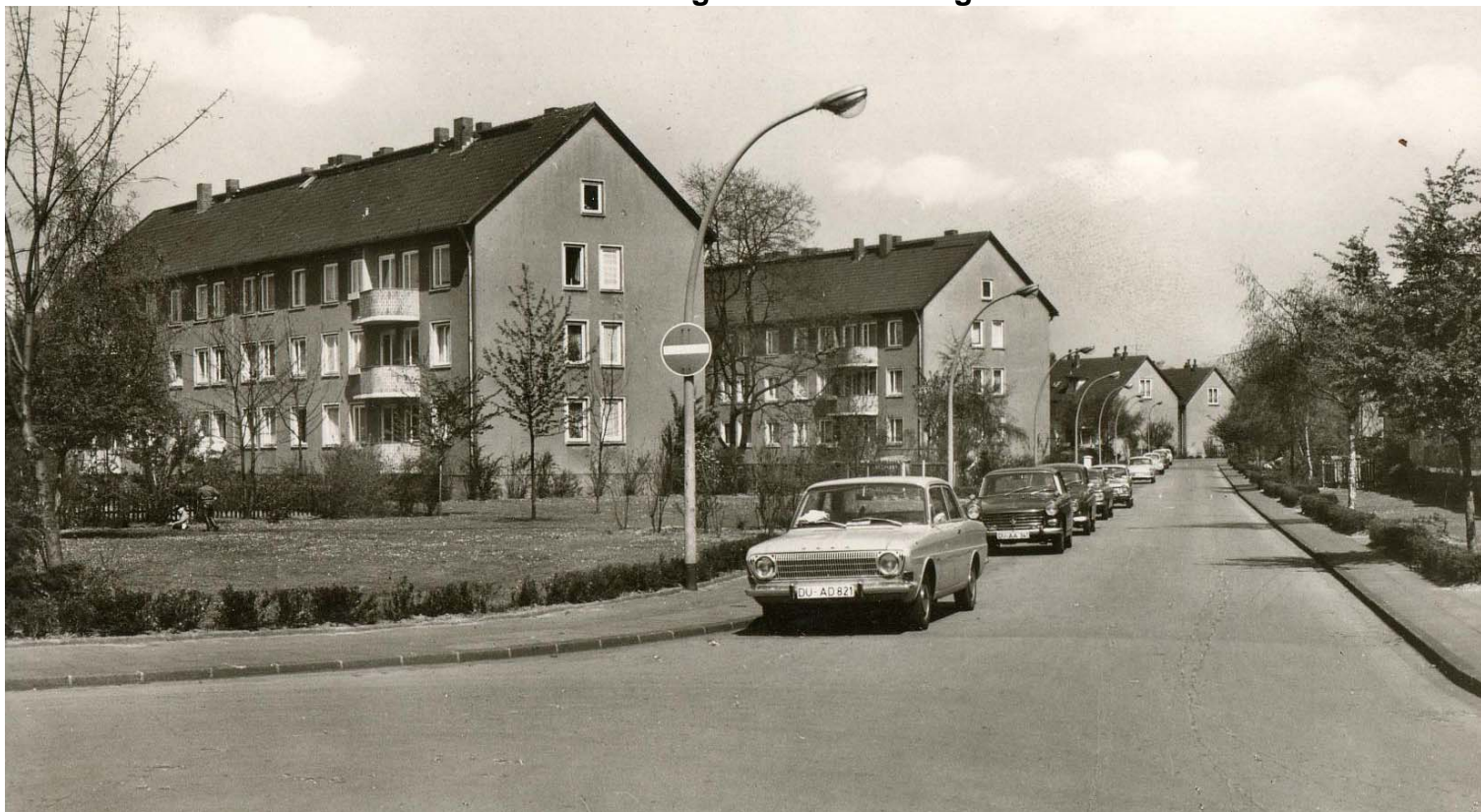
Reihenleuchten des Typs BAMAG U13H in Duisburg-Wedau / Allensteiner Ring, Foto: Sammlung ProGaslicht e.V.
