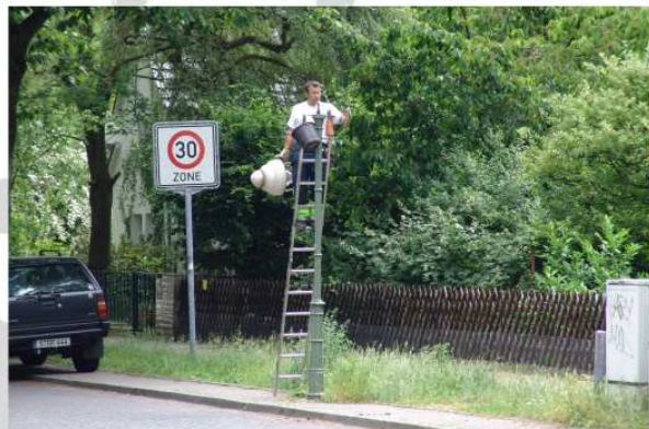
Wartung einer Gasaufsatzleuchte in Zehlendorf. Bild: Sammlung ProGaslicht
