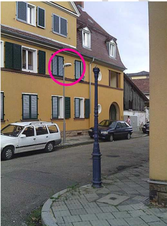
Der Gaskandelaber ist "enthauptet" und eine grässliche Stromleuchte zerstört das Ambiente. Bild: Klaus Gevatter
