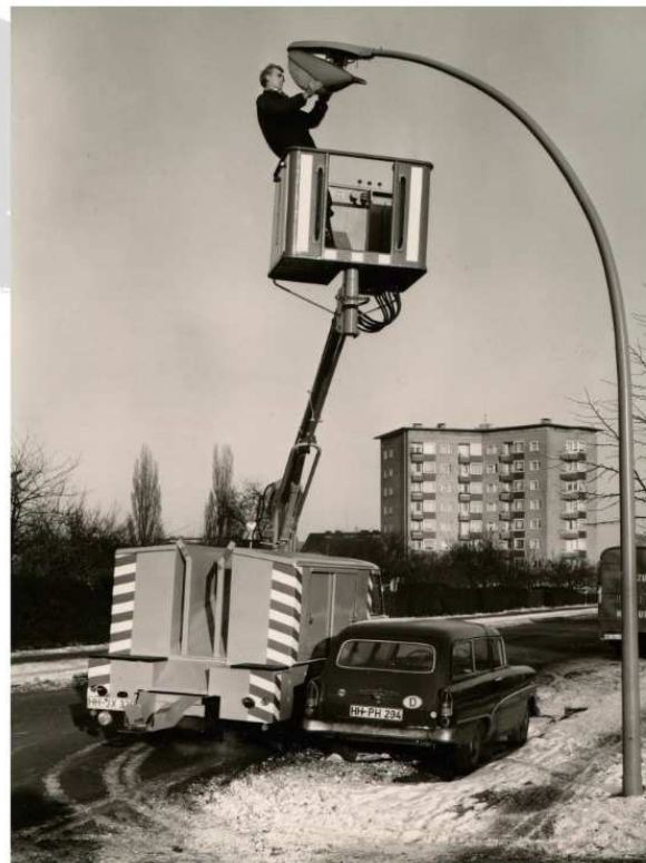
Hamburg um 1960: Eine Gasreihenleuchte wird gewartet. Bild: Sammlung Eckhardt
