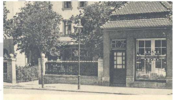
Marktredwitz am Bahnhofshotel. Oberes Bild: Bündelpfeiler mit Rech-Laterne "Freilicht" (1910). Unteres Bild: Gleiche Stelle, jetzt Gashängeleuchte an hohem Mast (1929).
