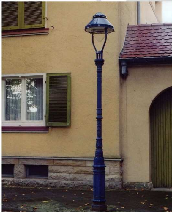
Gasauflatzleuchte auf historischem Gussmast am Reyherplatz in Mannheim-Käfertal. Bild: Bettina Grimm
