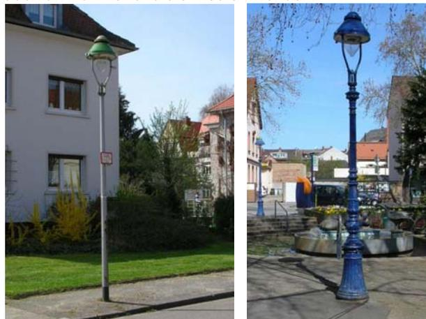
Links: Standard-Stahlmast in MA, rechts: Gusskandelaber Typ Mainz (mit Stadtwappen von Mannheim)
