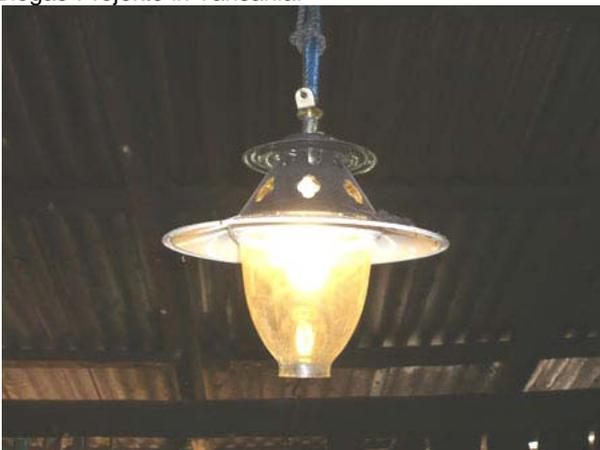
*Kambodscha, Biogas betriebene Lampe, Abb.: Smlg. ProGaslicht e.V.*
