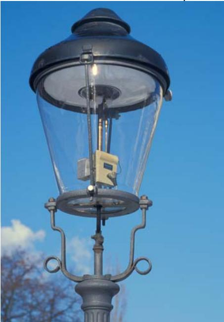
*Die Rundmantellaternen sind vierflammig, verwendet werden Dämmerungsschalter der Firma Trapp. (1)*
