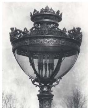
*Intensivleuchte mit Gruppenbrenner nach Denayrouze, Weltausstellung Paris 1900. Dank der Erhöhung des Netzdruckes auf 200 mm Wassersäule (20 mbar) konnte man eine bessere Lichtausbeute erhalten.*
