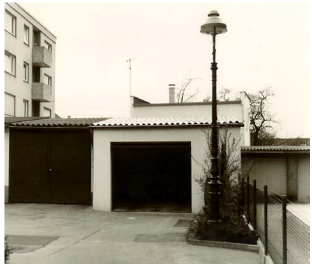
1974: Ca. ein Jahr später steht der Mast an seinem endgültigen Platz im Rosenbeet. Links neben dem Randstein sieht man die nachgeteerte Stelle des ersten Standplatzes.
