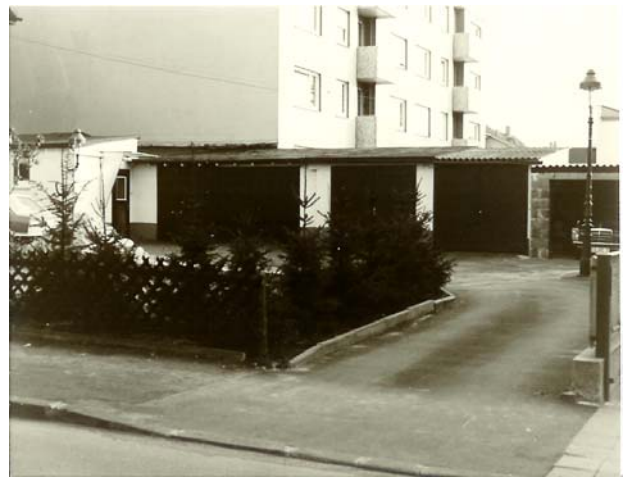
1973: Der Mast steht an seiner ursprünglichen Stelle auf dem Hof. Links an der Ecke des Anbaus sieht man den Wandarm mit der 2. Gaslampe.
