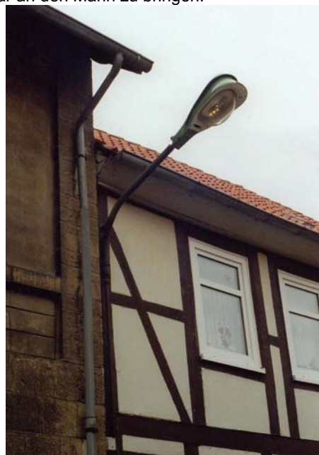
Seltene Kombination: Reihenleuchte am Wandarm, Königsutter (Abb. B. Grimm 2005)
