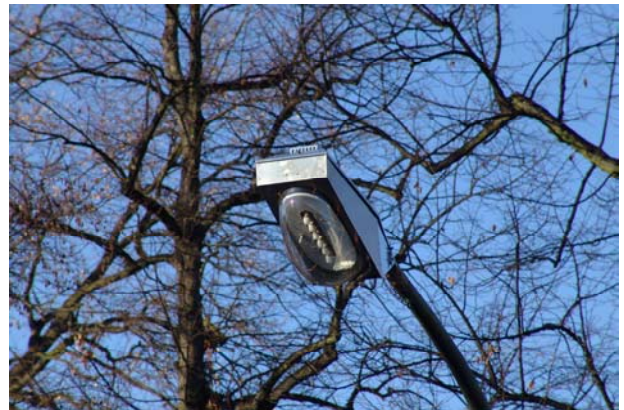
Moderner Gas-Reihenleuchtkopf (Abb.: Jurziczek 2005)
