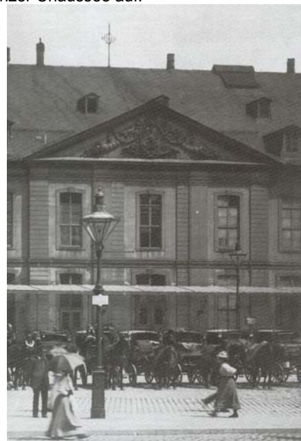
Rathenauplatz: Sechseckige weit auslandende Platzlaterne auf Frankfurter Adlerkandelaber, Anfang 20. Jh. Smlg. ProGaslicht
