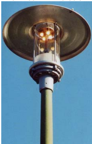
Moderne, 4-flammige Aufsatzleuchte. Foto: B.Grimm
