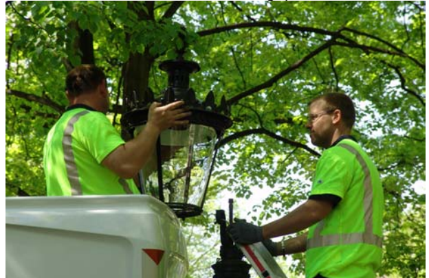
Montage der reparierten Leuchten am 24.4.2009 / Jur
