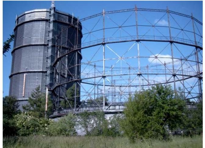
Der große MAN Scheiben-Gasbehälter mit den zwei MAN Teleskop-Gasbehältern in Augsburg
