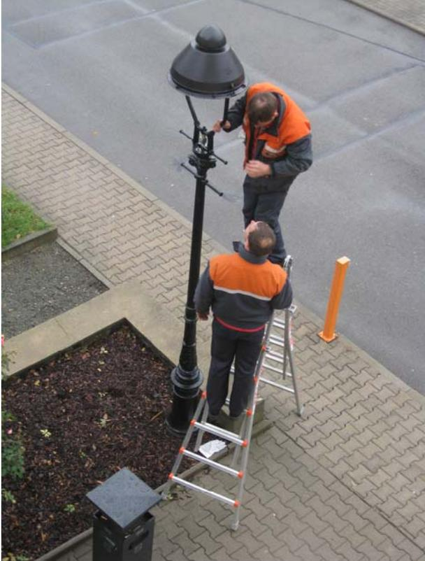
*Laterne Nr. 3 , Aufsatzleuchte mit Glasglocke des Modells Leistner auf einem verzierten gusseisernen Mast des Modells Zwickau. Diese Laterne ging im Jahr 2000 in Zwickau außer Betrieb. Letzte Montagearbeiten am 30.10.2008 auf dem Betriebsgelände der EV Greiz*
