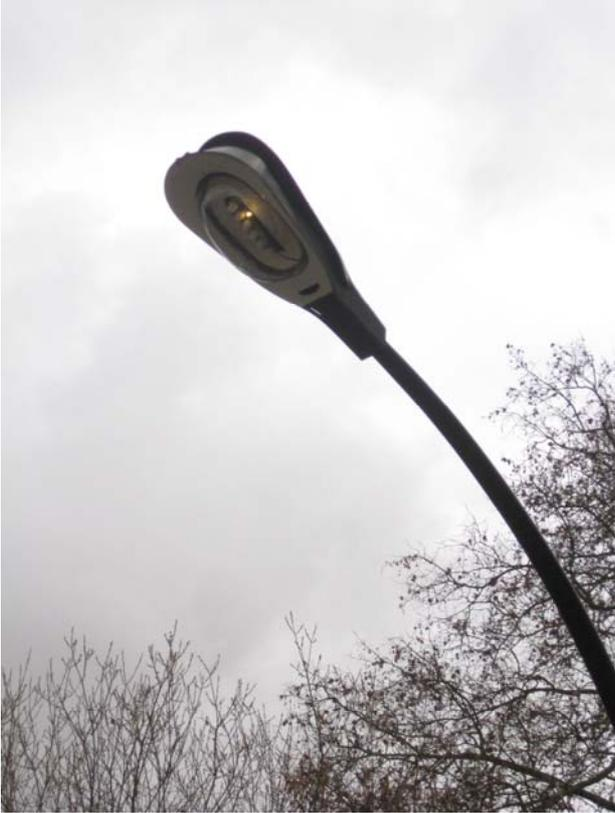
*Laterne Nr. 9, Reihenleuchte der Firma Schneider aus Hamm in Westfalen. Die Leuchte sitzt auf einem gebogenen Peitschenmast aus Walzstahl und ist mit einem sechsflammigen Gruppenbrenner in Reihenanordnung ausgestattet. Die Leuchte besitzt ein Dämmerungsschaltersystem der Firma Kalin aus Frankfurt. Aus der Mainmetropole stammt allerdings nicht die Schalttechnik, sondern die komplette Laterne, die bis 2005 dort in Betrieb war.*
